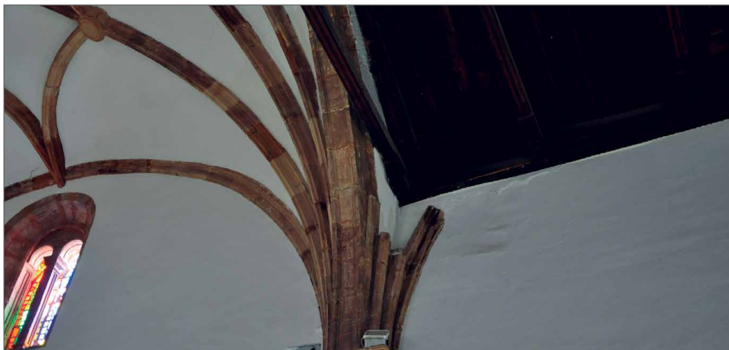
Fig. 22 Nervios incompletos sobre el arco toral
