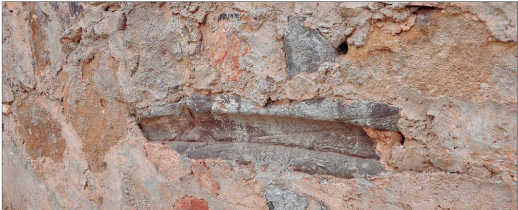
Fig. 60 Restos de la antigua capilla de San Benito reutilizados en la construcción de la actual sacristía
