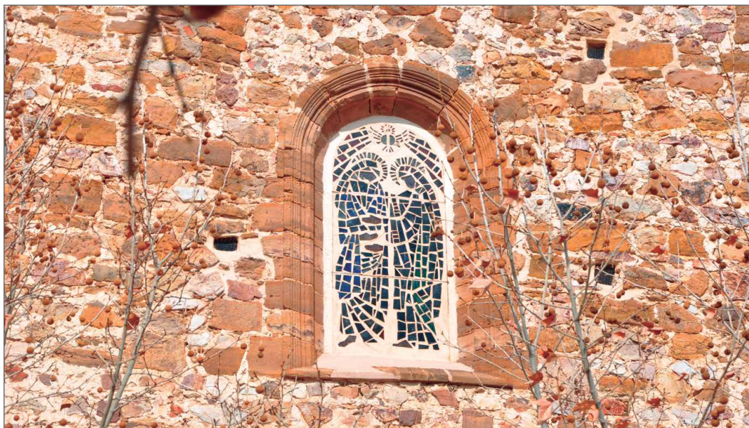
Fig. 20 Detalle de una de las ventanas diseñadas por Egas
