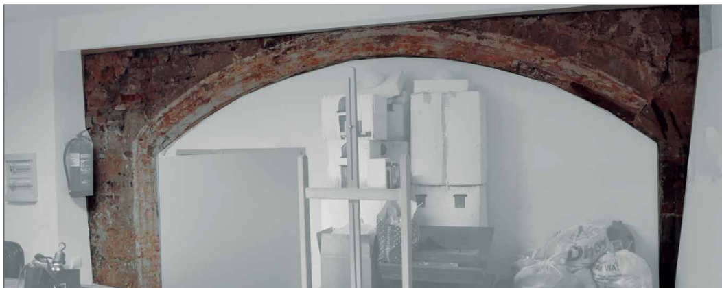
Fig. 6 Arco rebajado, conservado hoy día bajo la torre
